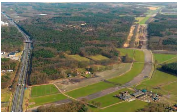
Figuur 14 Buisleidingstraat en bestaande 150kV verbinding bij de Brabantse wal. Het tracéalternatief Paars ligt in het bosgebied noordwestelijk (op de foto links) van de buisleidingstraat (foto uit 2009)
