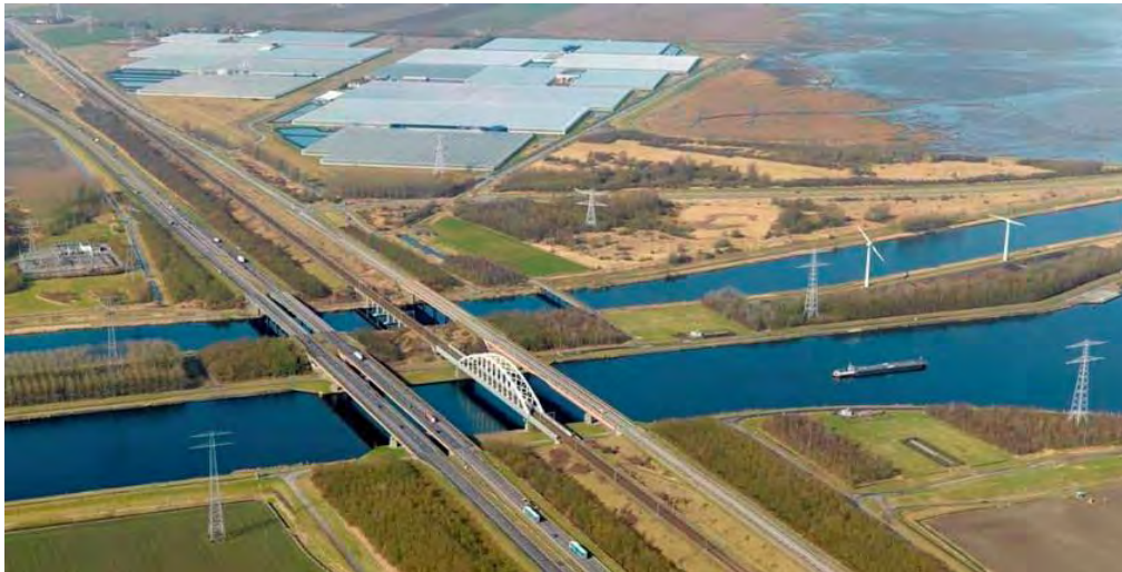
Figuur 13 Situatie bij Rilland en Schelde-Rijnkanaal. Gezien vanaf de westelijke oever (foto uit 2009)
