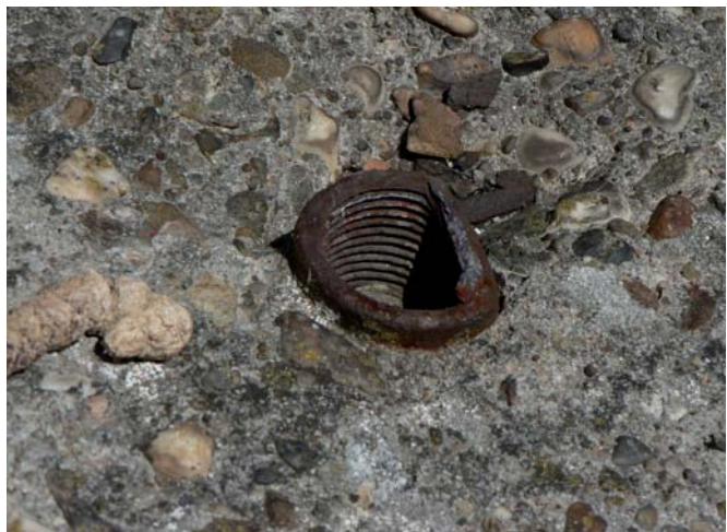
Figuur 25. Detail van koker met schroefdraad voor bevestiging van meetbout.
