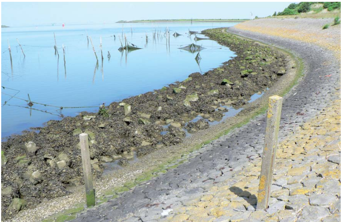
Figuur 11. Twee betonnen palen bij kazemat VII, mogelijk resten van een hek uit de Koude Oorlog
