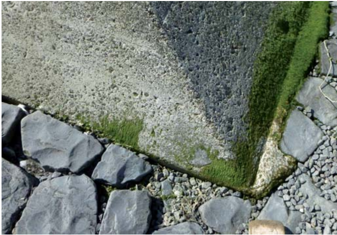
Figuur 16. Detail van betonplaat dat laat zien dat beton lokaal gestort is.
