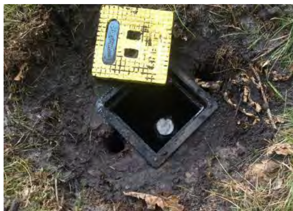
figuur 3: schroefanker afgewerkt met putje
