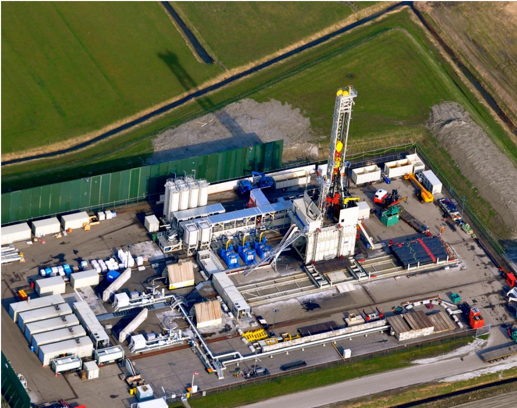
Figuur 2 Boorinstallatie inclusief boortoren en geluidswanden. Deze installatie staat meestal enkele maanden op locatie.
