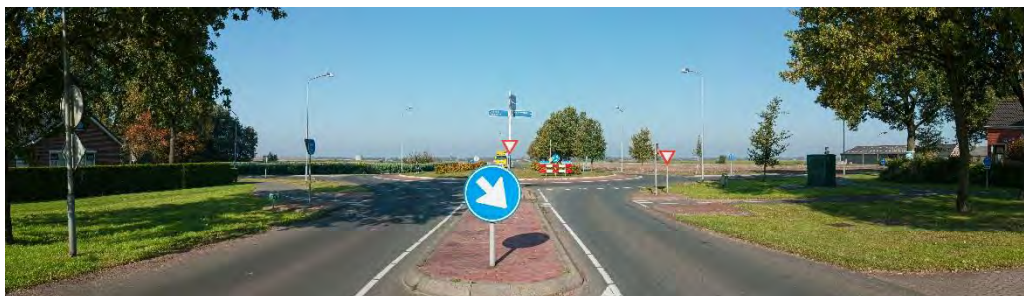
Figuur 3.1 Foto huidige situatie Eerste Exloërmond
