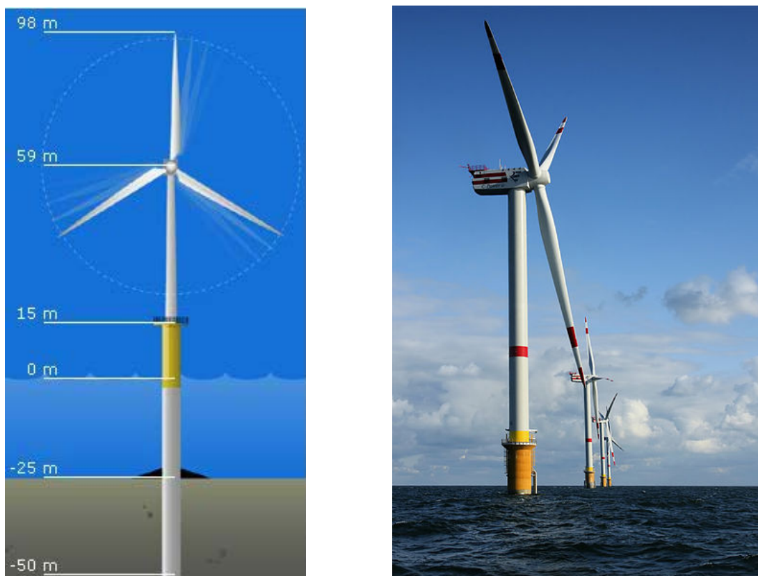
Figuur 6-9 Links: afmetingen van een paal in het Prinses Amalia park (foto van website: www.prinsesamaliawindpark.eu ; Rechts: foto van de 5MW turbines op de Thornton Bank
