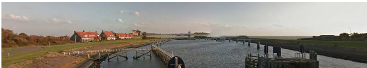
Figuur 5.3 - Situatie Kornwerderzand, foto in zuidelijke richting, met achtergrond sluis, beoogde locatie HDD-boring
