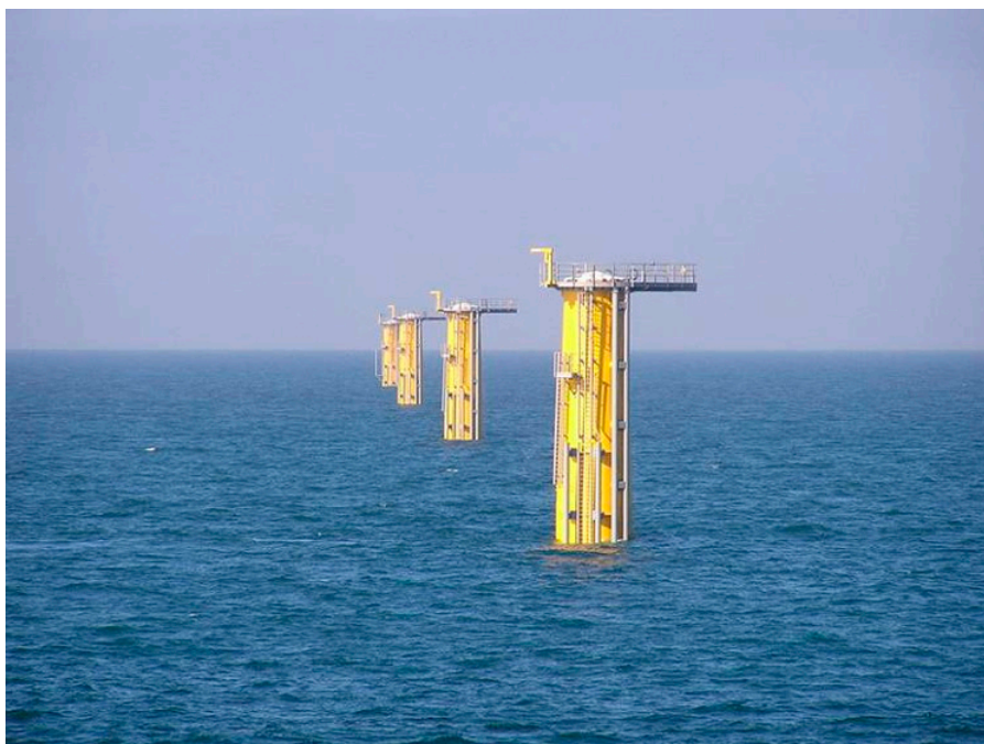
Figuur 6-11 Foto van een funderingspaal van een turbine in het Prinses Amalia park (foto van website: http://www.prinsesamaliawindpark.eu/ )
