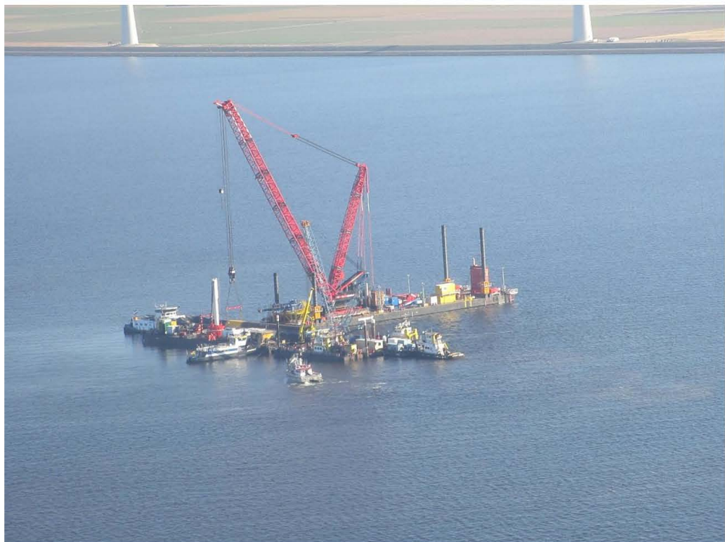
Figuur 2 Foto's van de aanleg van windturbines van windpark Noordoostpolder (heinstallatie op het water) (foto: C. Heunks)
