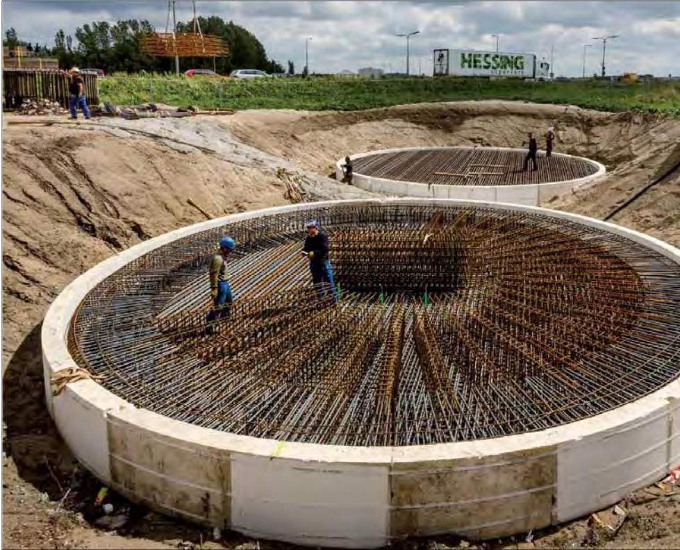
Afbeelding 3. Voorbeeld van een fundering van een hoogspanningsmast en impressie van de hiertoe aangelegde bouwput. Bron: http://www.zuid-west380kv.nl .
