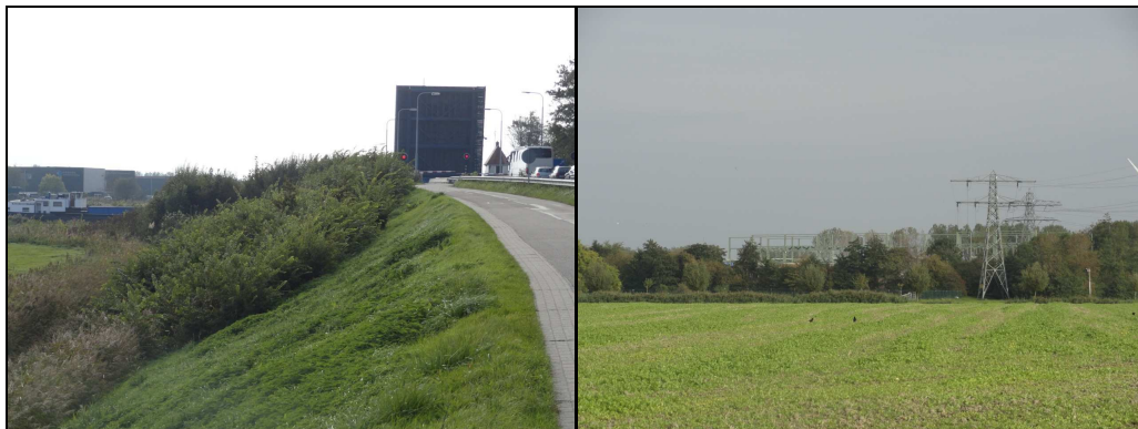
Figuur 3 Verhoogde berm met struweel langs N31 te Harlingen, nabij kruising met Van Harinxmakanaal (foto links); laatste deel tracé door akker naar Trafostation bij Herbaijum (foto rechts).
