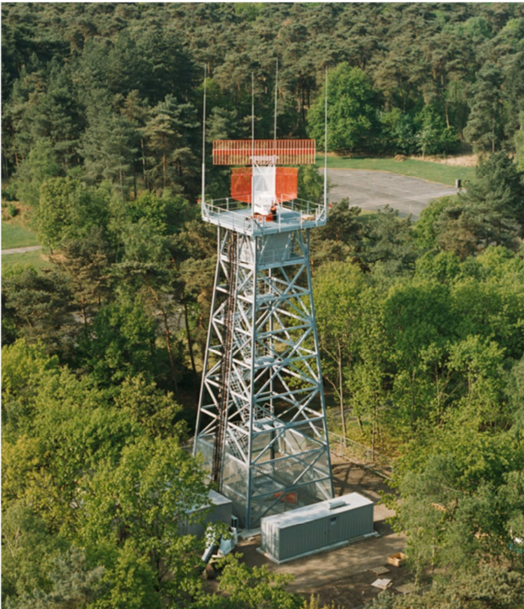
Figuur 1. De MASS primaire verkeersleidingsradar met daarbovenop de antenne van de secundaire radar.
