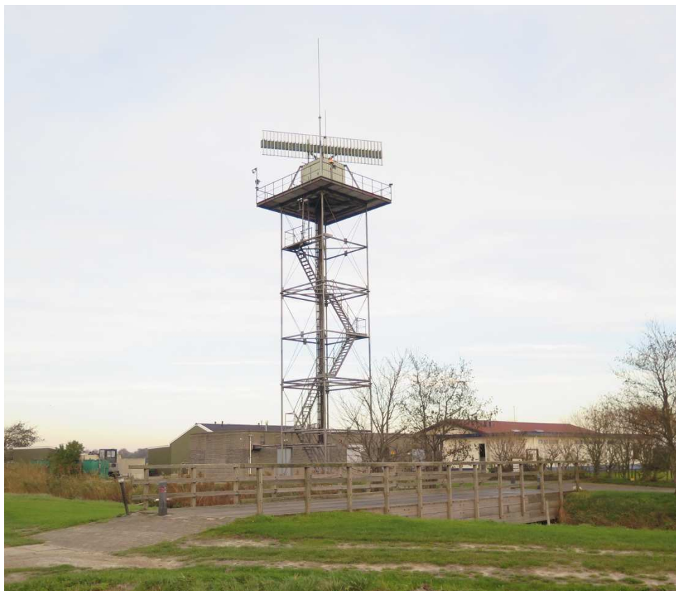
Figuur 15 De huidige secundaire radar op vliegbasis De Kooy in Den Helder.
