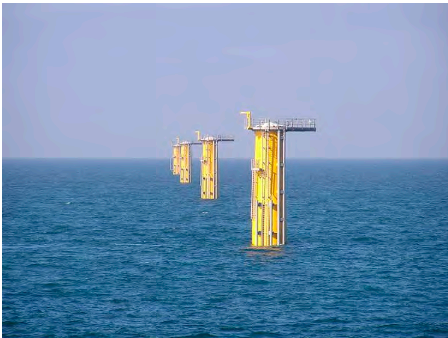
Figuur 6-11 Foto van een funderingspaal van een turbine in het Prinses Amalia park (foto van website: http://www.prinsesamaliawindpark.eu/ )
