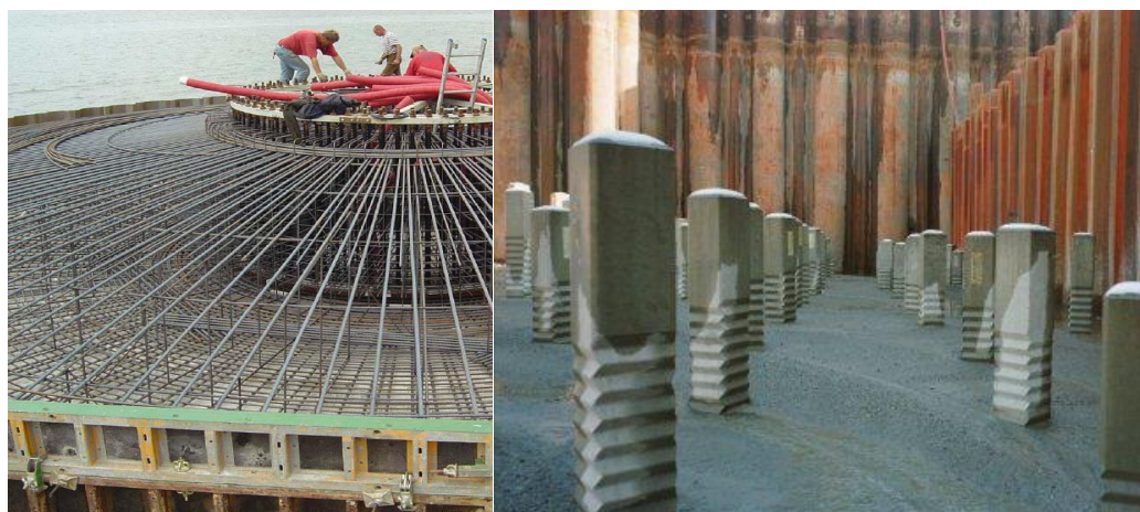
Figuur 1.23 Damwandconstructie en bewapening voor de fundering
