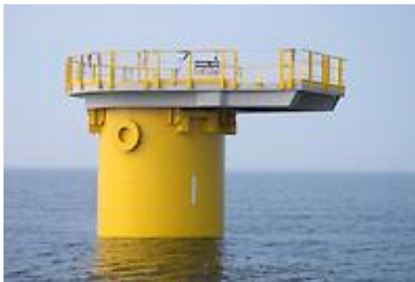
Figuur 1.21 Illustratie monopile
