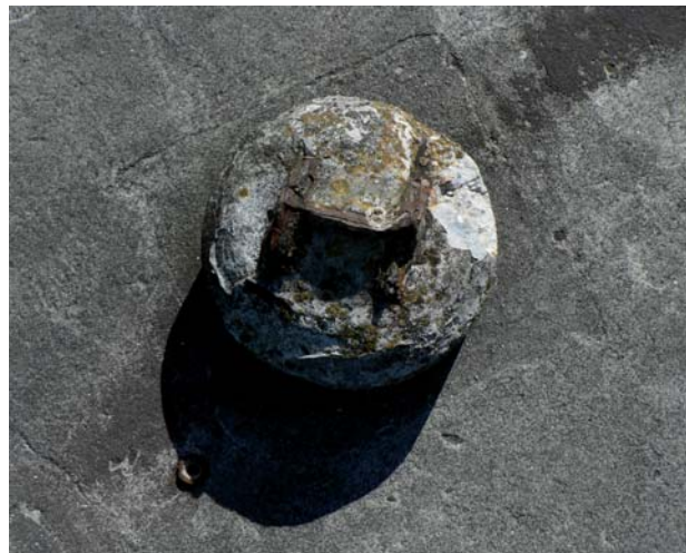
Figuur 19. Detail van I-balk in betonnen omhulsel met rechthoekige afdruk eromheen.
