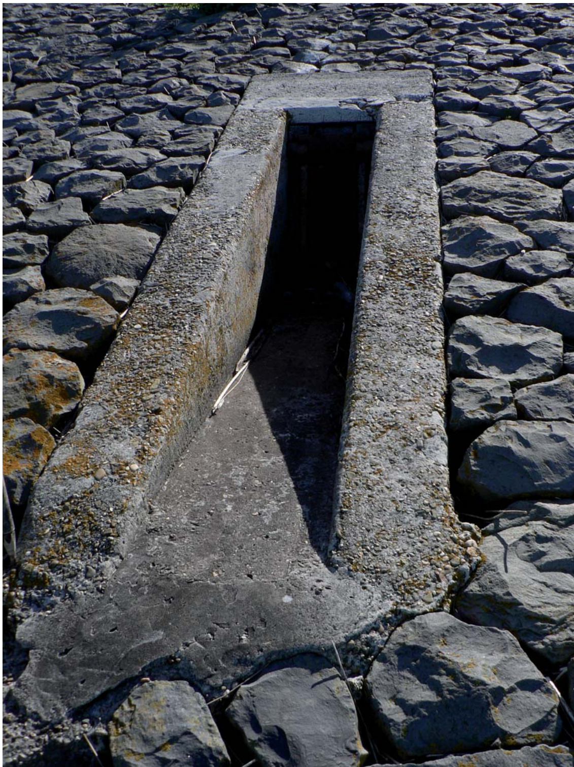
Figuur 8. Betonnen afvoergoot voor rioolwater, bij kazemat VII (spoor 500).
