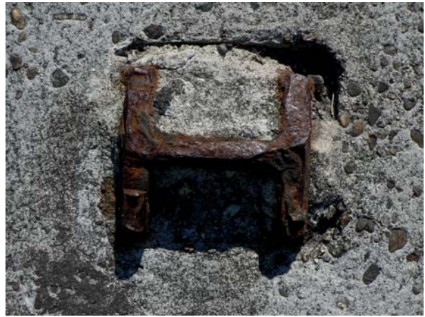
Figuur 17. Detail van I-balk in een opgevulde, rechthoekige uitsparing.
