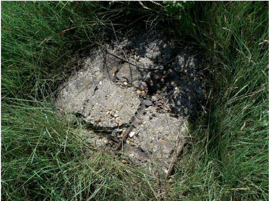
Figuur 28. Betonnen fundering met onbekende functie in de zone met resten van Nederlandse infanteriever-sperringen bij Kornwerderzand (spoor 506).
