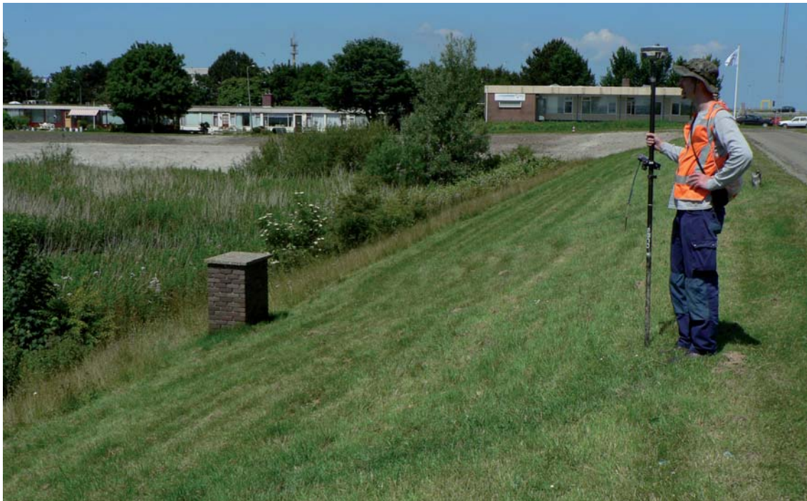
Figuur 12. Donkere verkleuring in het gras op het buitentalud van westelijke dijk van Voorhaven bij Den Oever op een mogelijke stelling, kijkend in noordelijke richting.
