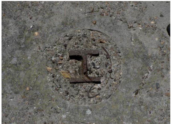
Figuur 24. Detail van I-balk in opgevulde ronde uitsparing met zichtbare bewapening.
