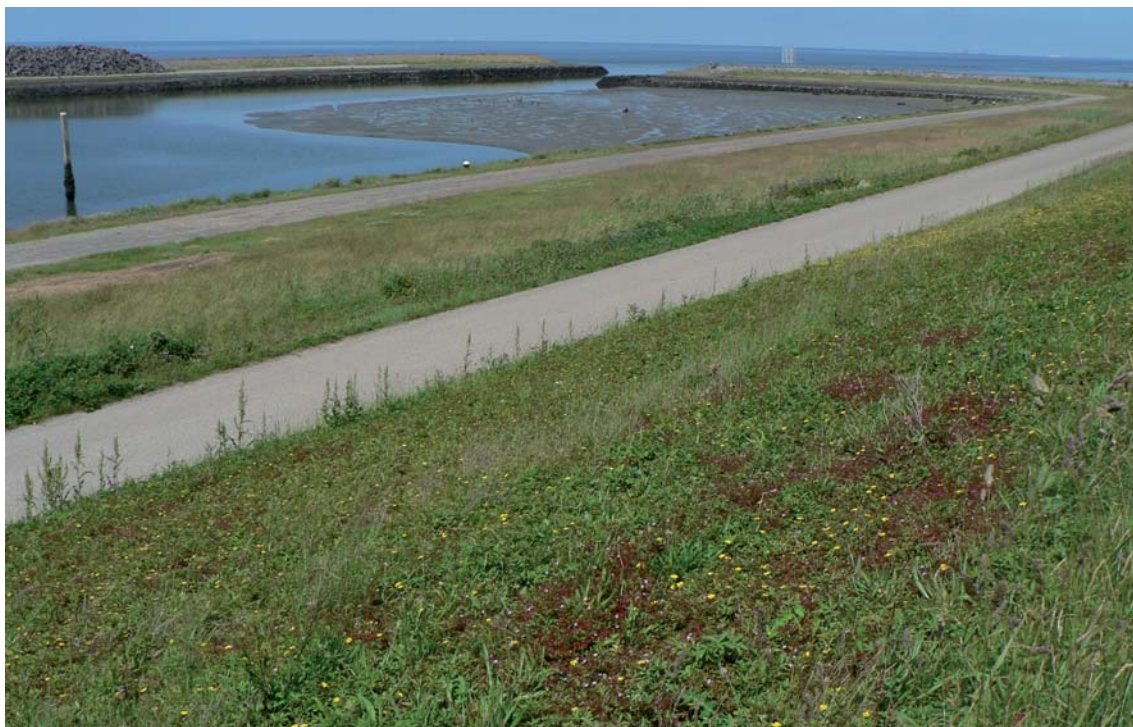
Figuur 26. Overzicht van de situatie bij Breezanddijk, kijkend in noordoostelijke richting.
