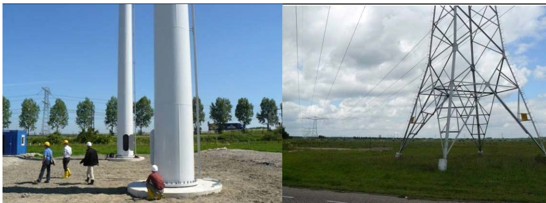
Figuur 4.8 Ruimtebeslag van Wintrack- en vakwerkmast
