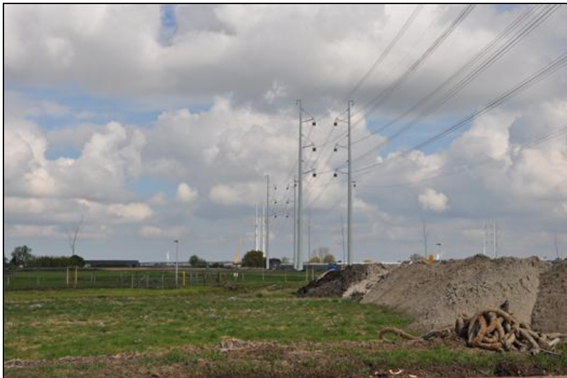
Figuur 1: 380 kV hoogspanningsleiding (bron: www.zuidwest380kv.createsend.com ).
