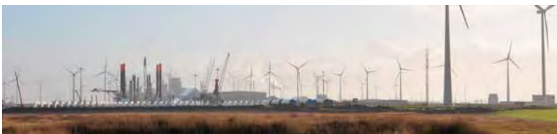
koppeling windenergie met industrie | Eemshaven
