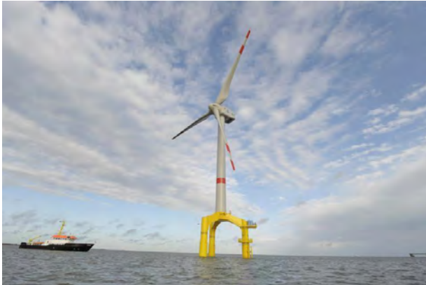
Figuur 1.5 Voorbeeld van een tripile fundatie 2
