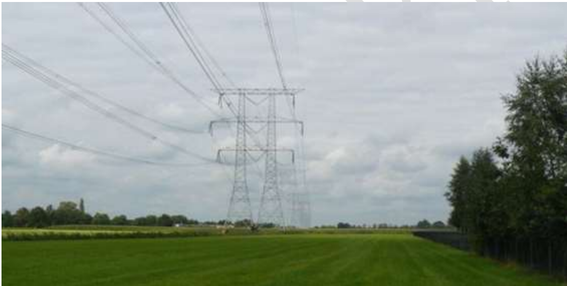
Afbeelding 60 Bestaande 3 circuits 380kV hoogspanningsverbinding van de landelijke ring tussen Geertruidenberg en Tilburg in tracédeel [3]. De nieuwe verbindingen wordt bij tracéalternatief C380b naast de bestaande 380kV hoogspanningsverbinding gebouwd, waarna deze wordt afgebroken. De hartlijn van de verbinding verschuift daardoor.
