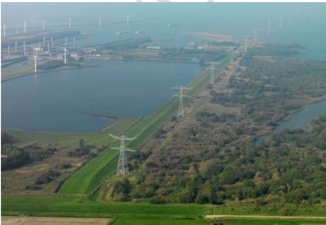
Foto 9 Bestaande situatie met de 380kV-verbinding aan de zuidzijde van het Markiezaat.
