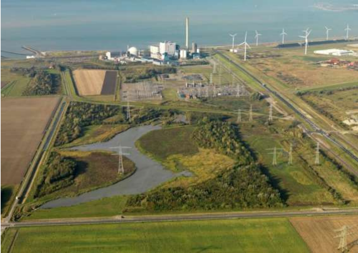
Foto 3 Het 380kV-station en het 150kV-station bij Borssele, Op de achtergrond de kerncentrale en de kolencentrale. Rechts het Sloegebied met windturbines en op de voorgrond het Sloebos doorsneden door een aantal hoogspanningsverbindingen.
