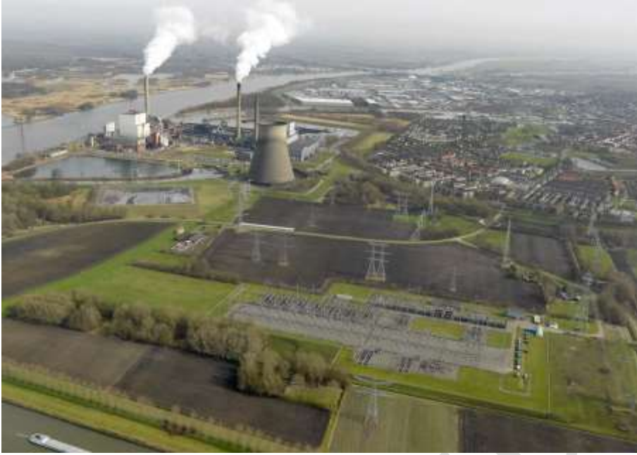
Foto 14 Geertruidenberg met elektriciteitscentrale en (voorgond) het 380kV-station waar de bestaande 380kV-verbinding uit Borssele is verbonden met de landelijke ring.
