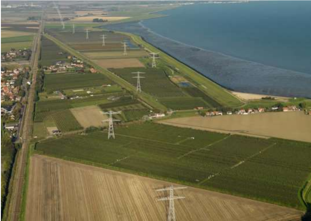
Foto 8 380kV-verbinding in de noordrand van Zuid-Beveland. Links de spoorlijn Bergen op Zoom - Goes met ten zuiden (links) daarvan Krabbendijke, rechts de Oosterschelde.
