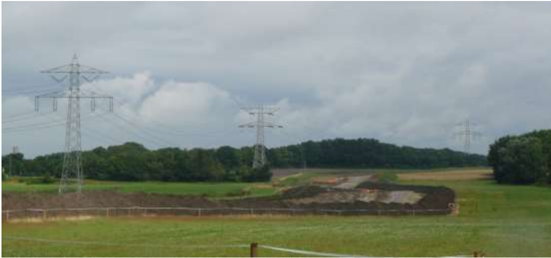
Foto 12 Bestaande 150kV naast de buisleidingenstraat bij de Brabantse Wal. In de buisleidingenstraat kunnen nieuwe leidingen worden gelegd. Dat leidt regelmatig –zoals ook op de foto- tot het openleggen van een strook binnen de buisleidingenstraat.
