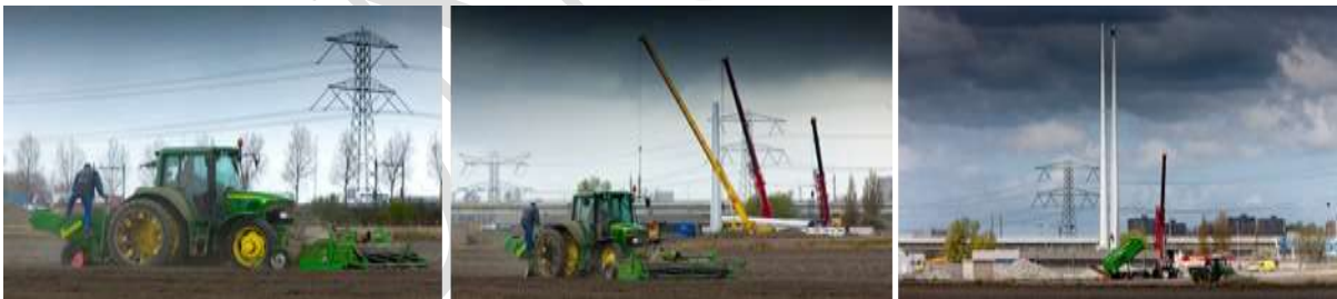
Foto 1 Het bouwen van een mast
