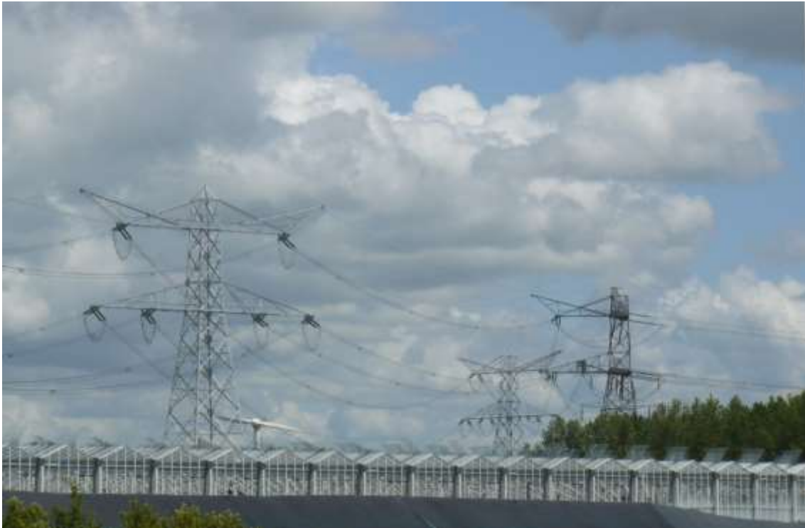
Foto 10 380kV-verbinding in het glastuinbouwgebied bij Rilland, met de 380kV aantakking richting Zandvliet in België.
