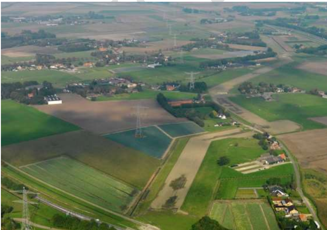
Foto 11 Buisleidingenstraat en 380kV-verbinding in het kampenlandschap westelijk van Oud Gastel.
