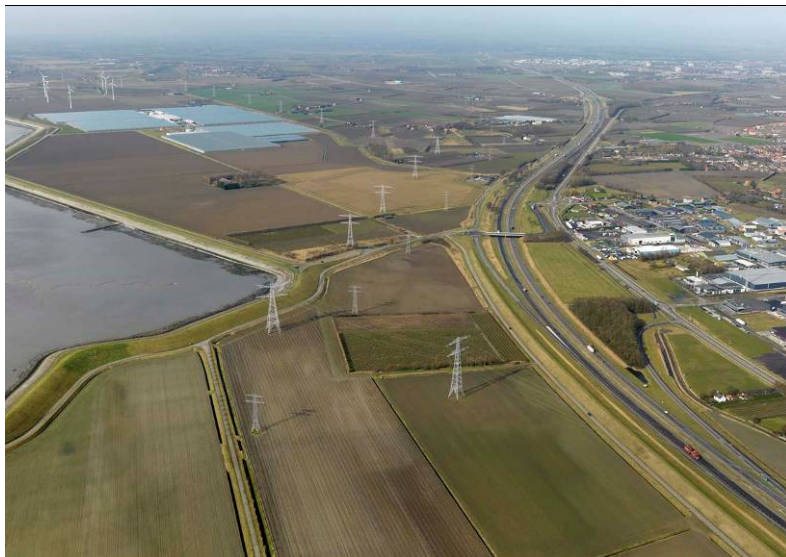
Figuur 7.8 Ten zuidoosten van Kapelle kruisen de bestaande 150kV-verbinding en de 380kV-verbinding elkaar en komt veel infrastructuur samen in het smalle deel van Zuid-Beveland
