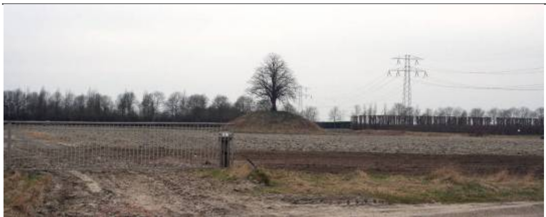
Figuur 6.21 Vliedberg 't Hof Blaemskinderen aan de 's Gravenpolderseweg. Rechts de bestaande 150kV-verbinding
