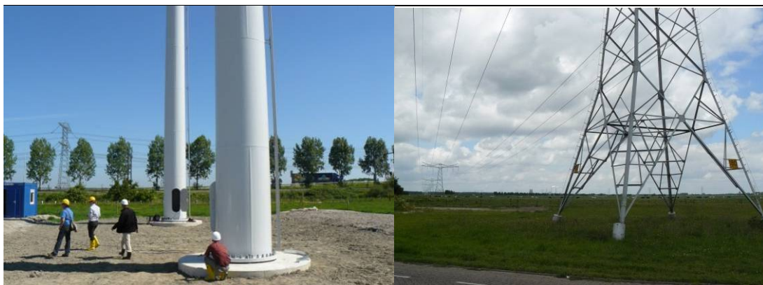
Figuur 4.8 Ruimtebeslag van Wintrack- en vakwerkmast
