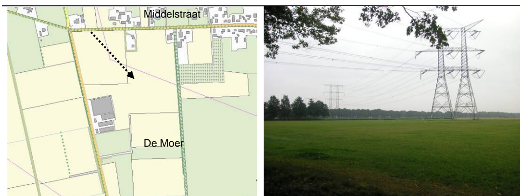
Figuur 5.33 Door het gebied lopen twee hoogspanningsverbindingen, op de afbeelding is de 380kV-verbinding weergegeven bij de Moer
