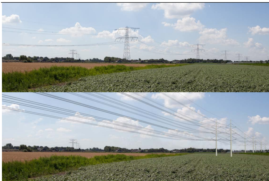
Figuur 8.48 Boven: Bestaande situatie tussen Standdaarbuiten en Roosendaal. Onder: Visualisatie van de gecombineerde verbinding in alternatief C380b.
