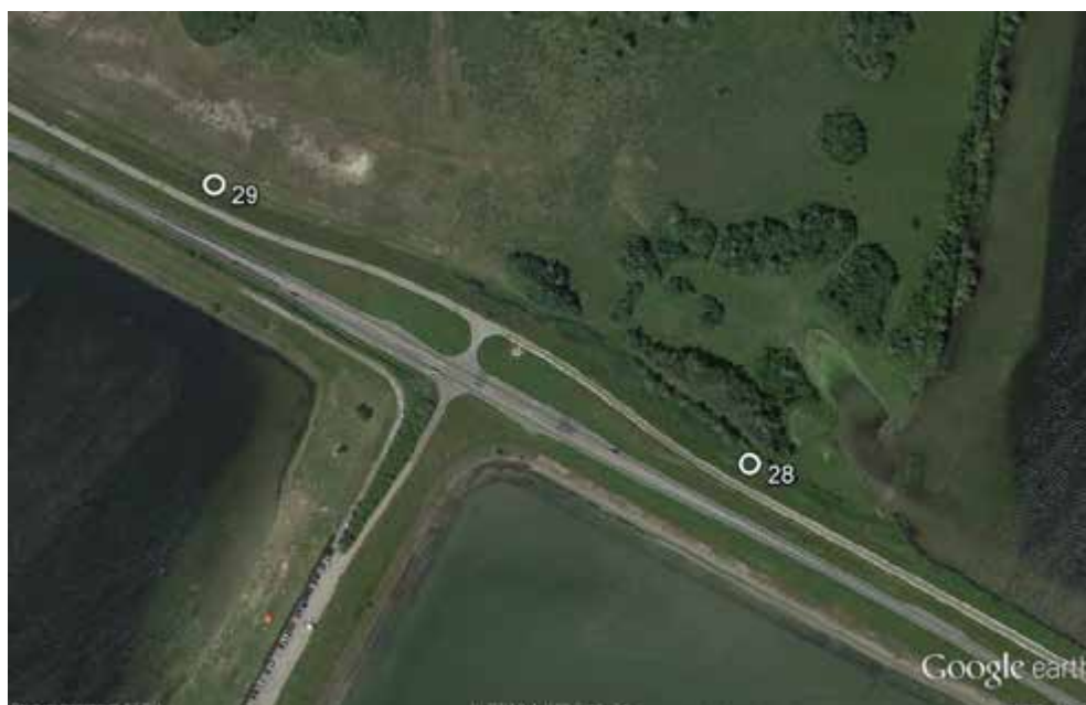
Figuur 2 De turbines 28 en 29 die deels in de EHS worden geplaatst.
