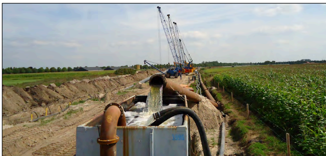
Figuur 4 - Boosterpomp welke het onttrokken grondwater verder pompt.
