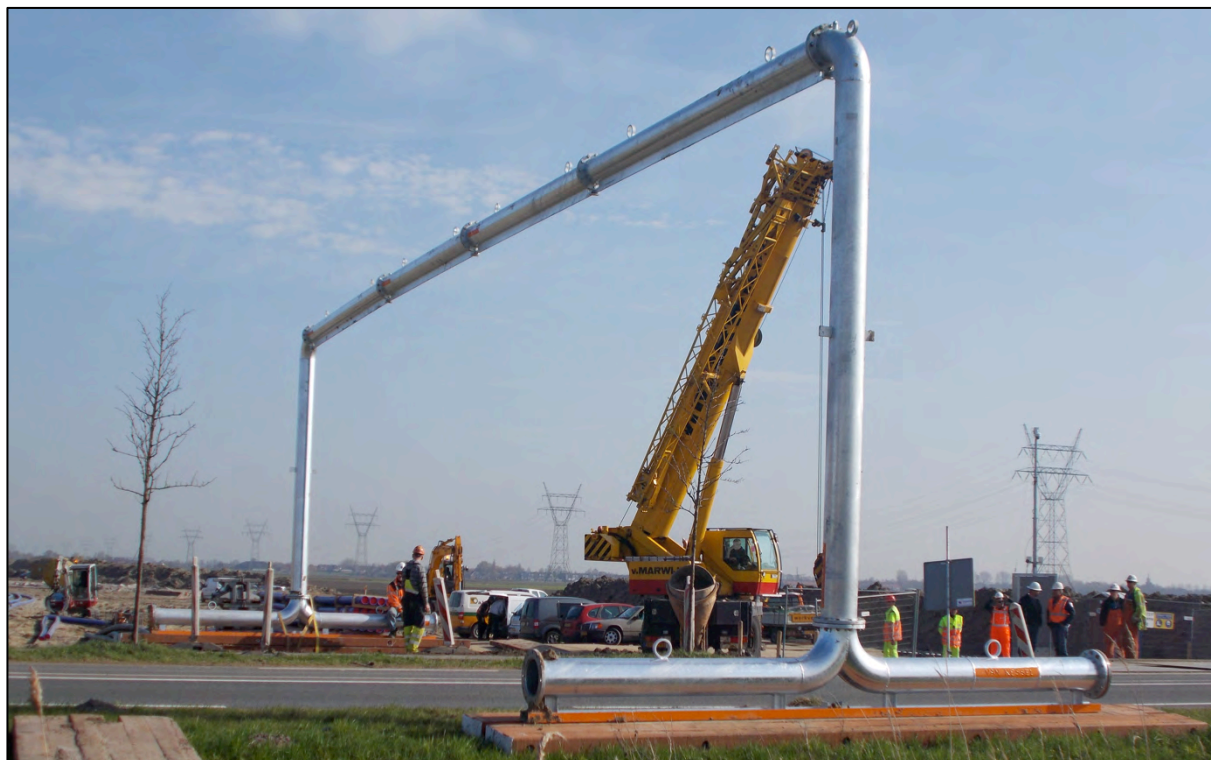
Figuur 3 - Leidingbrug/jumper over een weg.
