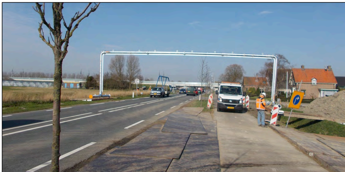
Figuur 2 - Leidingbrug/jumper over een weg.
