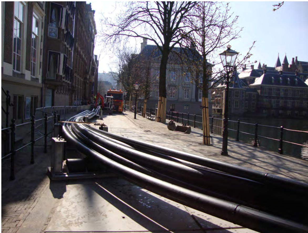
Figuur 8: leiding klaar voor intrekken
