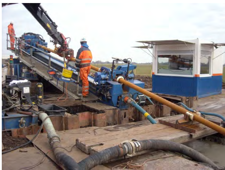
100t rig in actie
