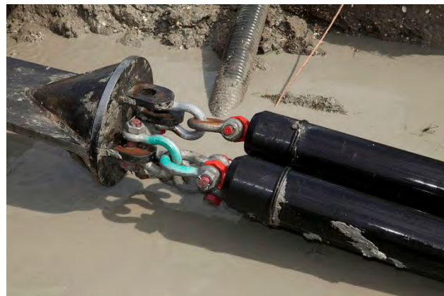
Trekkop, bundel PE pijpen
