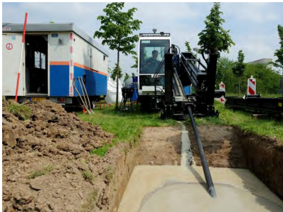
27t rig in actie
