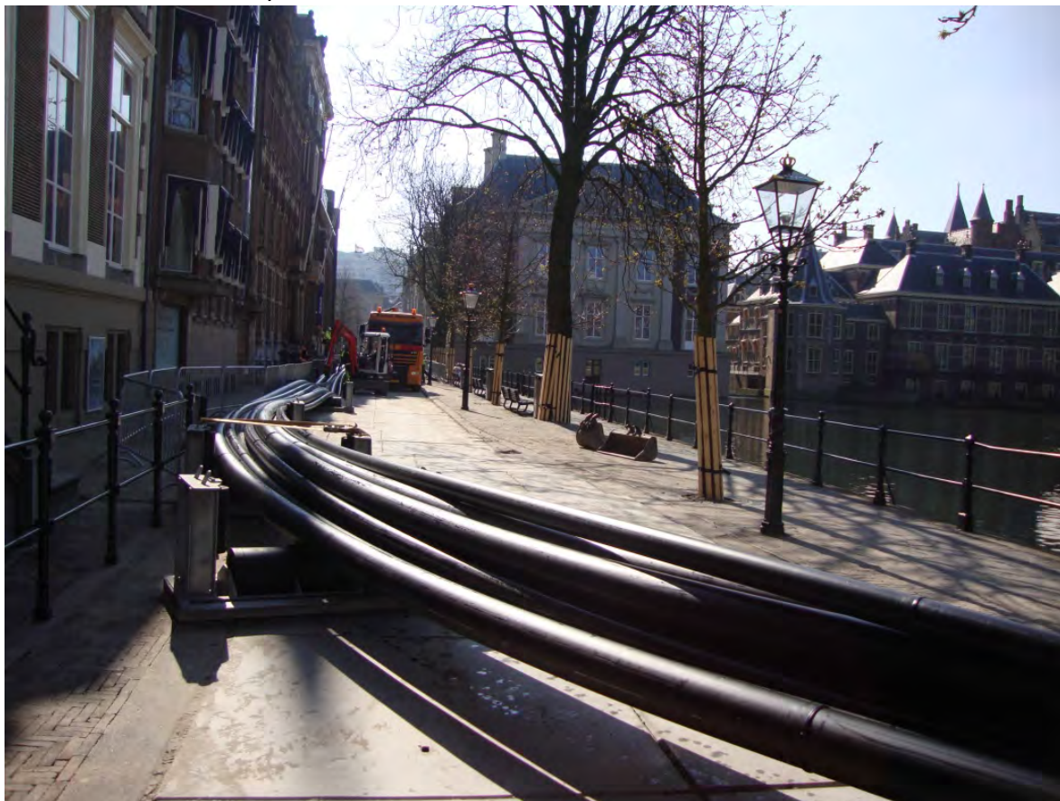
Figuur 8: leiding klaar voor intrekken
