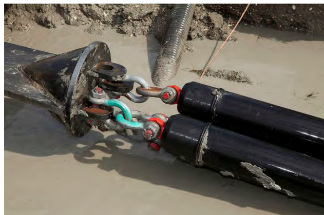
Trekkop, bundel PE pijpen
