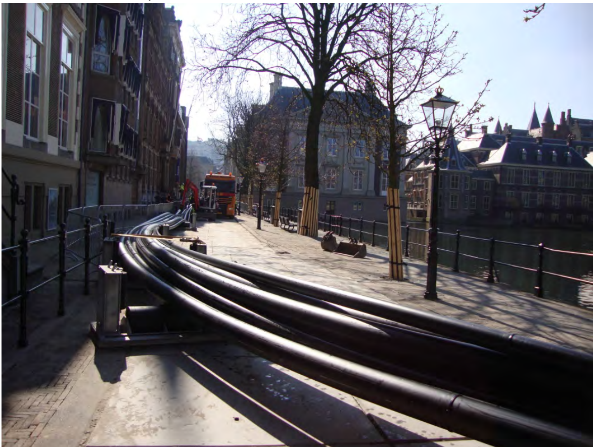
Figuur 8: leiding klaar voor intrekken
