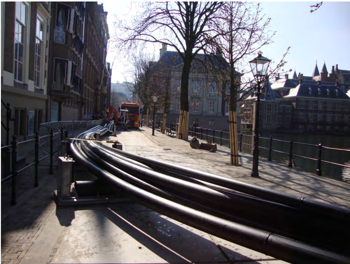
Figuur 8: leiding klaar voor intrekken
