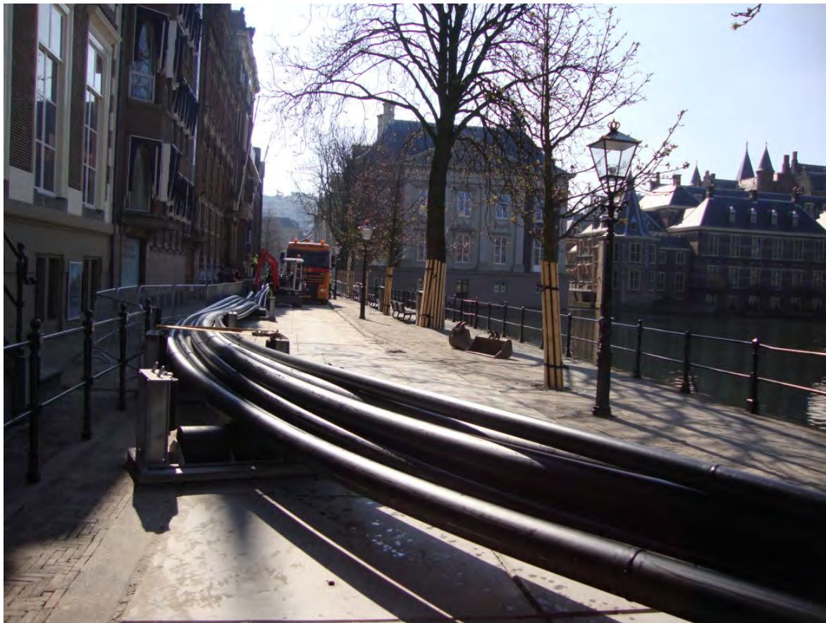
Figuur 8: leiding klaar voor intrekken
