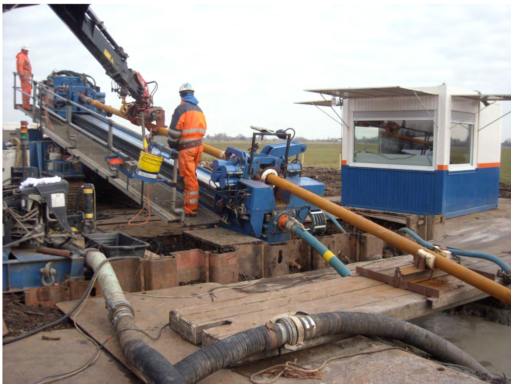
100t rig in actie
