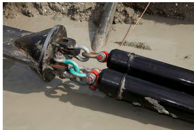
Trekkop, bundel PE pijpen
