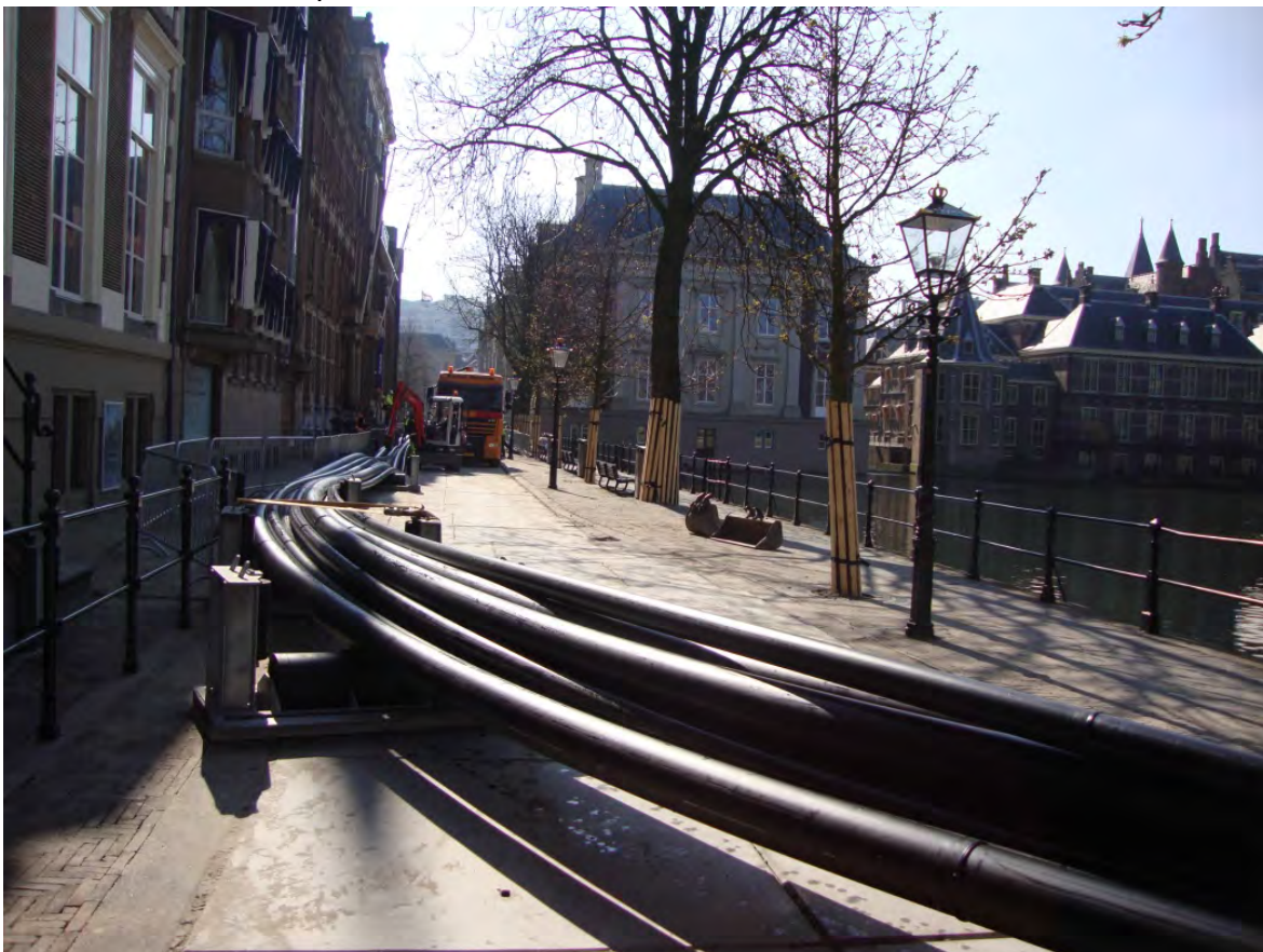
Figuur 8: leiding klaar voor intrekken
