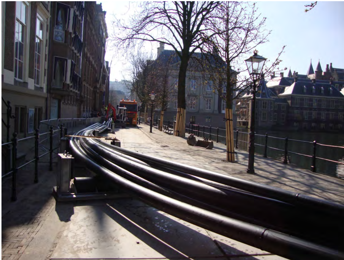
Figuur 8: leiding klaar voor intrekken
