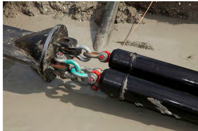
Trekkop, bundel PE pijpen
