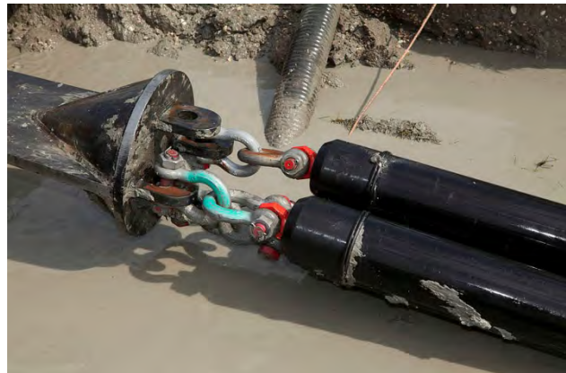
Trekkop, bundel PE pijpen
