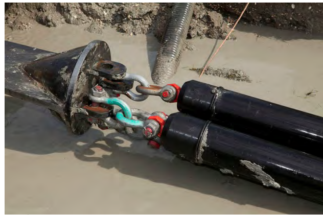
Trekkop, bundel PE pijpen
