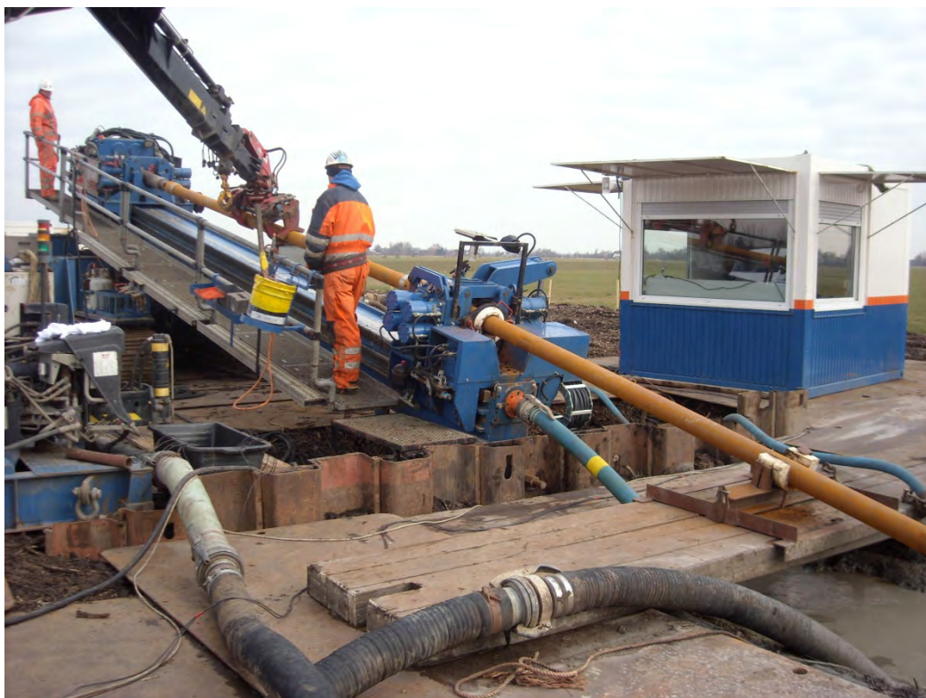
100t rig in actie
