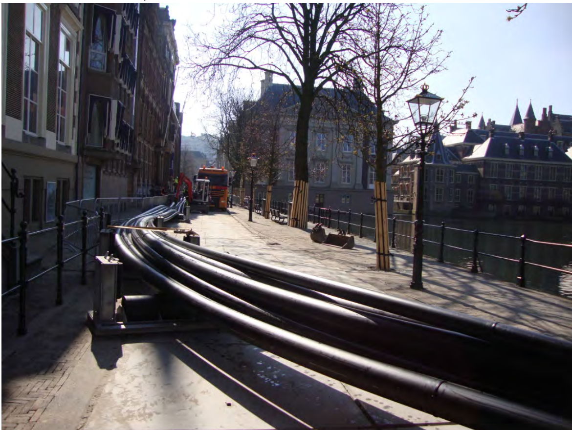
Figuur 8: leiding klaar voor intrekken
