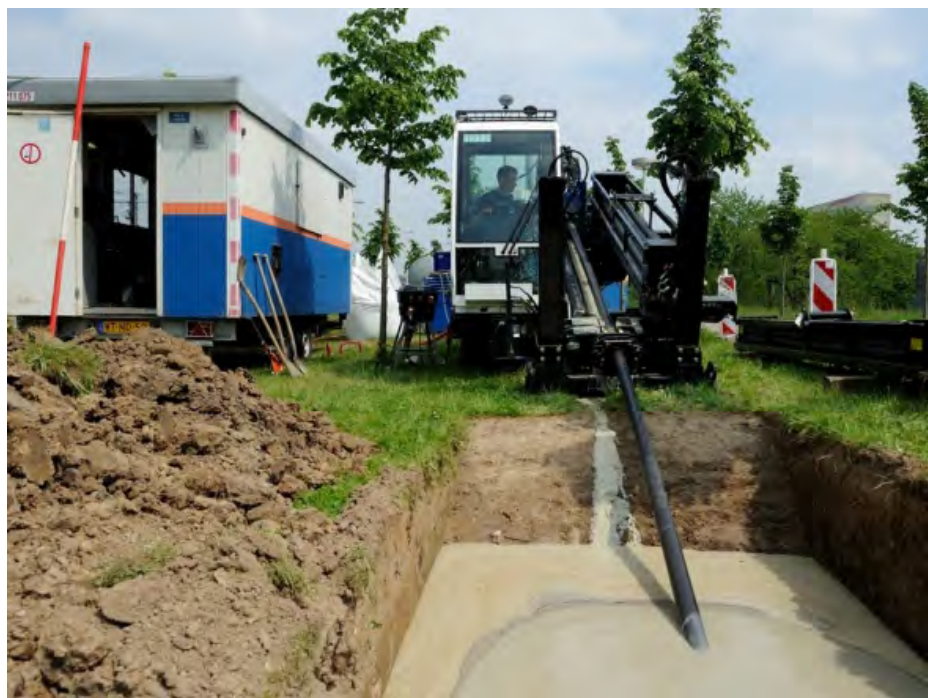
27t rig in actie
