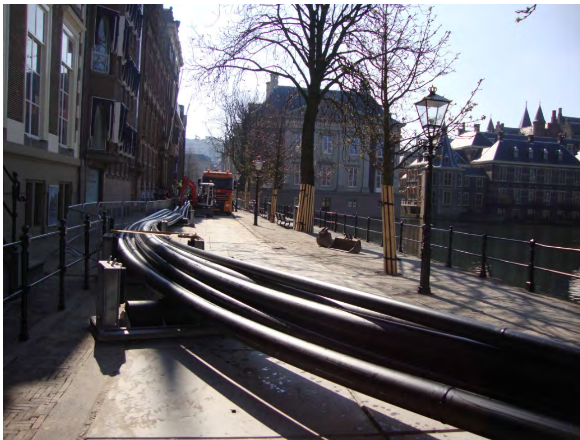
Figuur 8: leiding klaar voor intrekken
