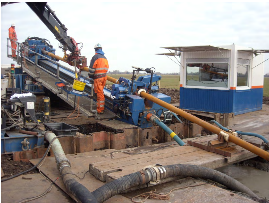
100t rig in actie
