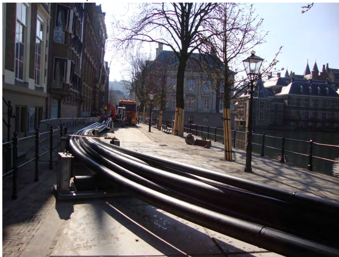
Figuur 8: leiding klaar voor intrekken
