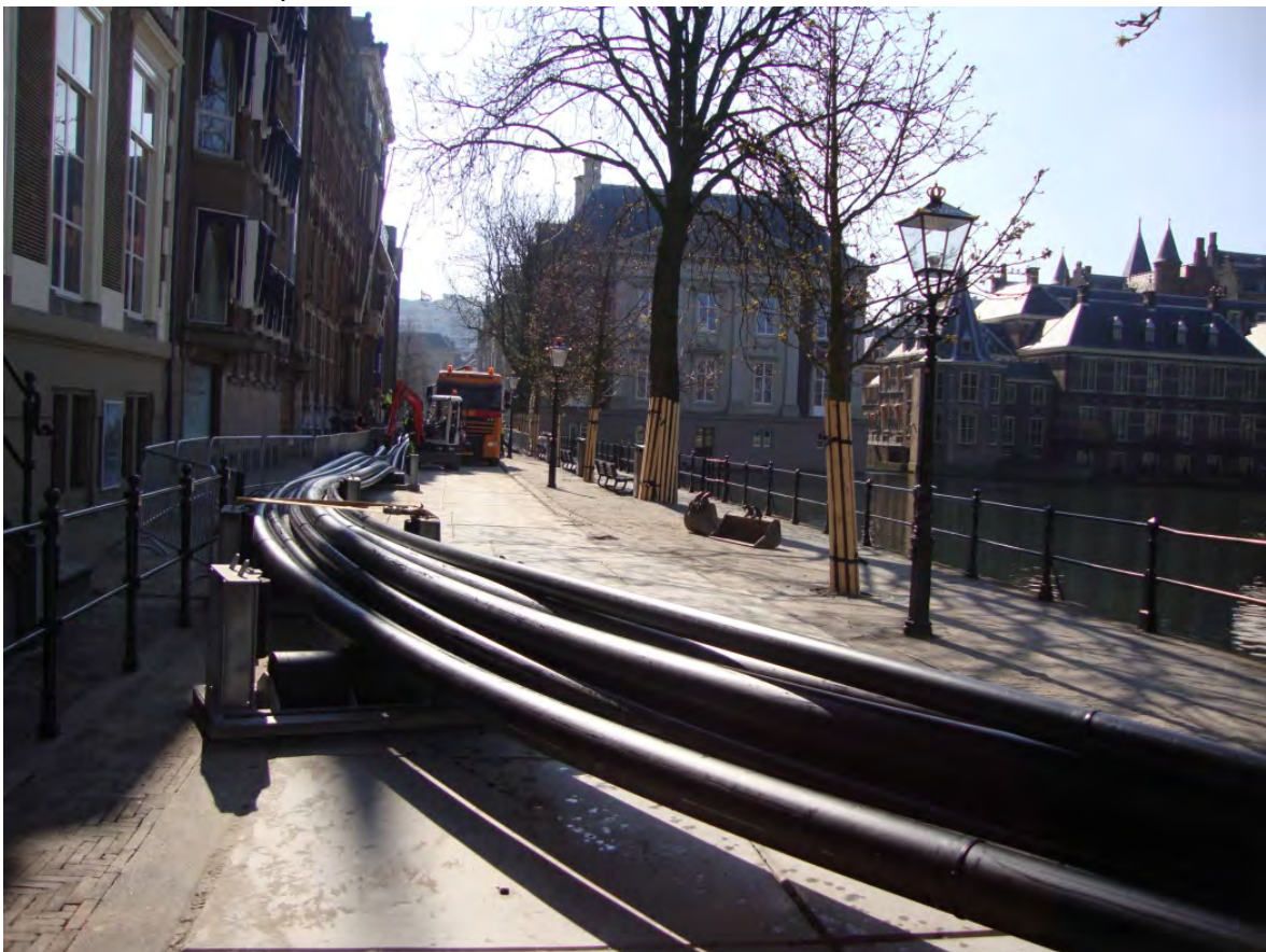
bundel klaar om te worden ingetrokken (Hofvijver)
