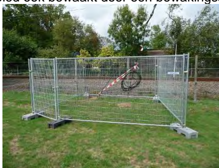
Afbakening van een grondverankering
