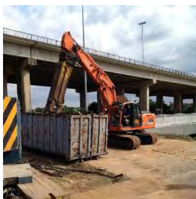
Afvoer van materiaal
