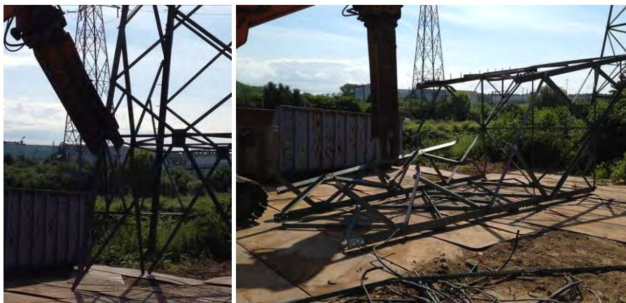
Knippen van mast elementen
