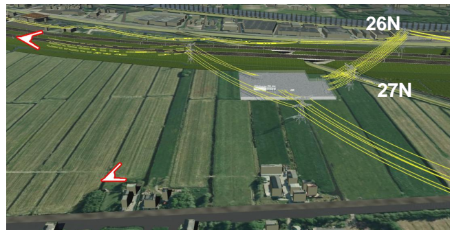
B2.1e. Modelsimulatie van de mogelijke situatie na realisatie van het transformatorstation op de locatie Kortrijk (III).
