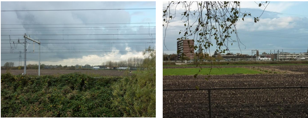
Figuur 14. De zone Ruwiel (VII), november 2009. Links gezien vanaf de weg langs het Amsterdam-Rijnkanaal met op de voorgrond de spoorlijn en rechts achter het tankstation Ruwiel. Rechts vanaf het tankstation Ruwiel, met linksachter een van de hoge woonblokken aan de oostzijde van het kanaal. Vergelijk ook de afbeeldingen in bijlage B.
