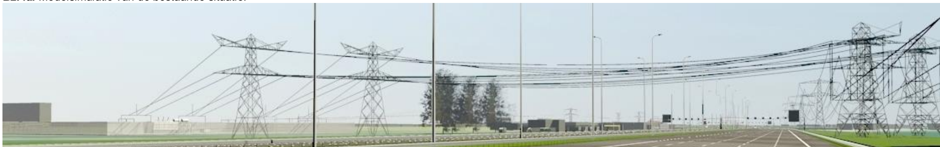
B2.4b. Modelsimulatie vanaf hetzelfde standpunt na realisatie van het transformatorstation op de locatie Ruwiel (VII). Links is de 150 kV-verbinding naar het bestaande transformatorstation Breukelen niet te zien doordat die daar juist buiten beeld op het station wordt aangesloten.
