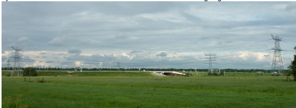
B2.7c. Zicht uit het noorden over de mogelijke stationslocatie naar de verhoogde A2 met de onderdoorgang van het spoor Breukelen-Woerden. Helemaal links en rechts de masten 105 en 104 van de 380 kV-verbinding Diemen-Krimpen. Aan de oostzijde van de A2, de masten 28, 27 en 26N (vier traversen) in de verzwaarde 150 kV-verbinding Lage Weide-Breukelen. Vergelijk de simulatie B2.2a.
