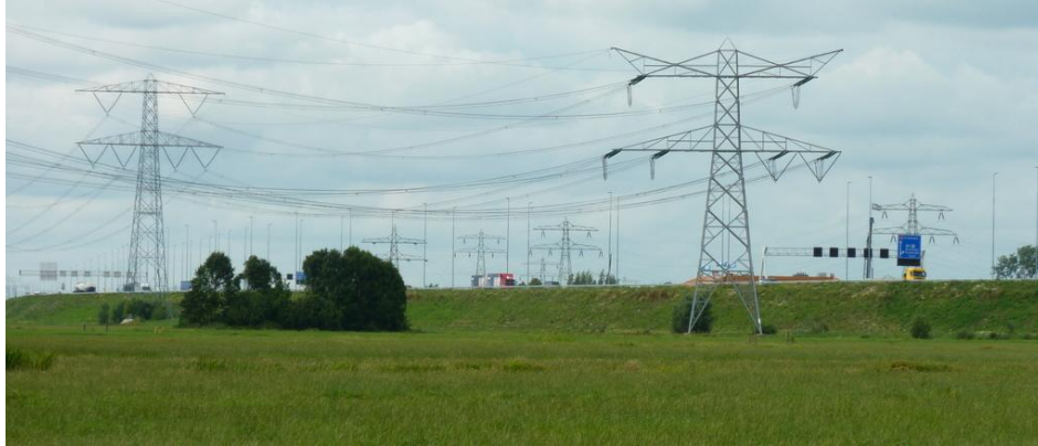
B2.7a. De knik in de 380 kV-verbinding Krimpen-Diemen, gezien uit het zuiden, over de mogelijke stationslocatie. Aan deze zijde van de A2 de masen 106 en 105. Aan de andere zijde van de A2 het niet verzwaarde deel van de 150 kV-verbinding Lage Weide-Breukelen.
