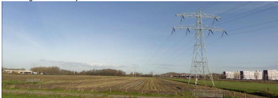
B2.8c. Zicht op de mogelijke stationslocatie vanaf de Corridor (Breukelerwaard) met het niet verzwaarde deel van de 150 kV-verbinding Lage Weide-Breukelen. Links het tankstation Ruwiel, rechts de woonblokken aan de overzijde van het kanaal. Beeld: Google Streetview.
