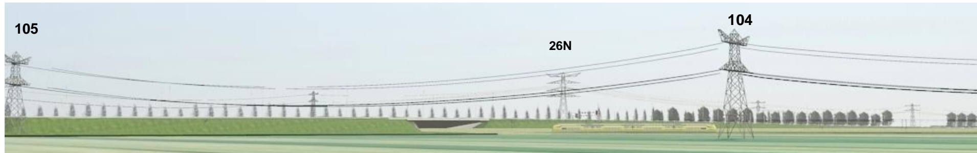
B2.2a. Modelsimulatie van de bestaande situatie. Op de voorgrond de 380 kV-verbinding Diemen-Krimpen met masten 104 en 105. Op de achtergrond de 150 kV-verbinding met onder meer de 8-armige mast 26N. Vergelijk de foto B2.7c.
