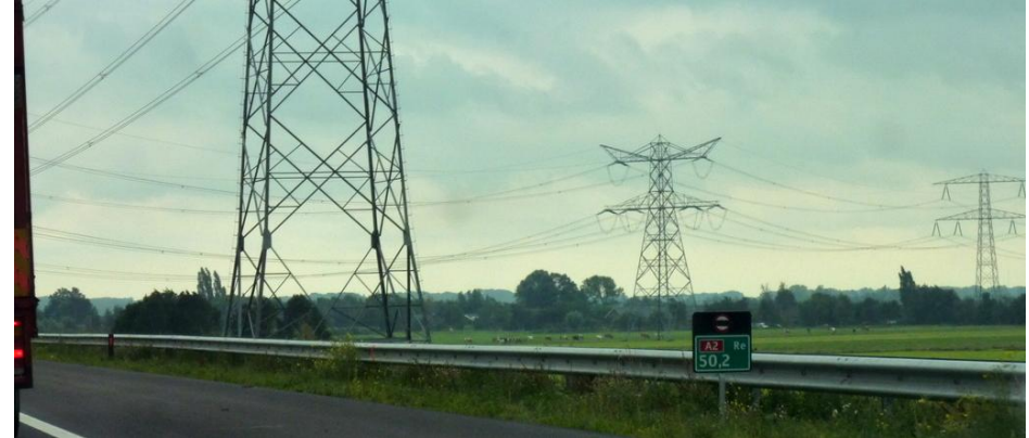
B2.7b. Zicht vanaf de A2 in zuidelijke richting bij Kortrijk, met van links naar rechts de masten 106, 104 en 103 van de 380 kV-verbinding Diemen-Krimpen; mast 105 is links juist buiten beeld. Vergelijk ook B2.7d en de simulatie B2.3a.
