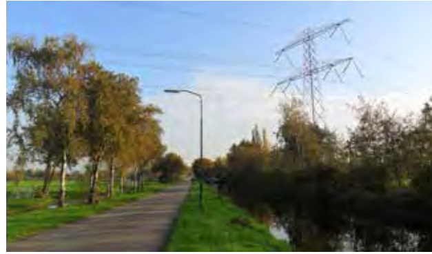
fig.: 4 Kortrijk met beplanting en brede sloten. op de achtergrond de 380kV lijn en de spoorlijn.
