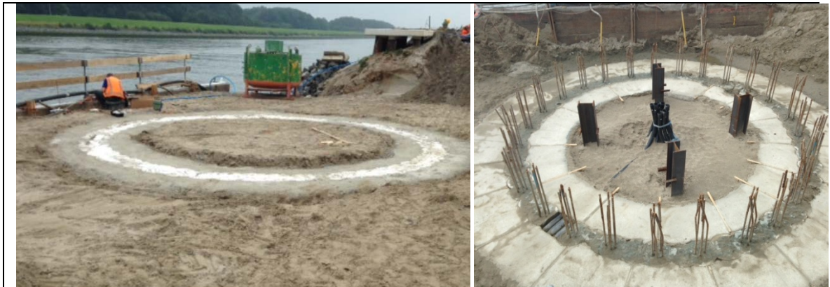
Figuur 5-2 Voorbeeld boorframe en boorpalenwand voor windpark Hartel II te Rotterdam (Ballast Nedam)
