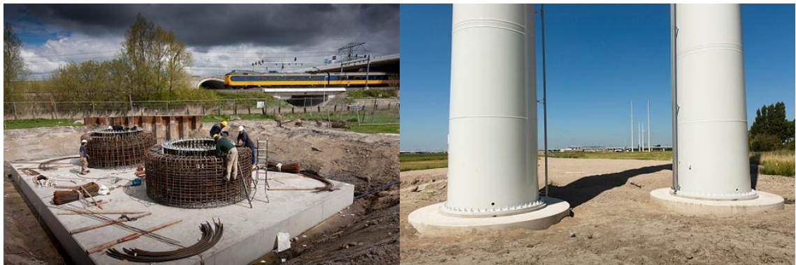
Figuur 2.2 Het openliggend fundament en de mastvoet na afwerking.
