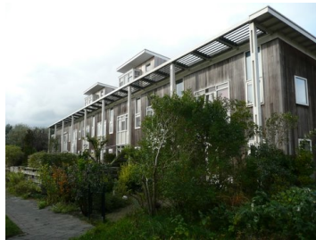
Groningen – Lewenborg / Drielanden Waterland 1996 124 eengezins koopwoningen 26 eengezins huurwoningen
