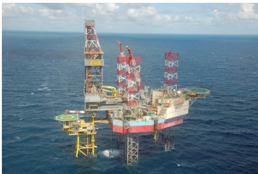
Figuur 1.2: Boorinstallatie (rechts) tijdens eerdere boring bij platform A18 (links), deels vergelijkbaar met platform B13
